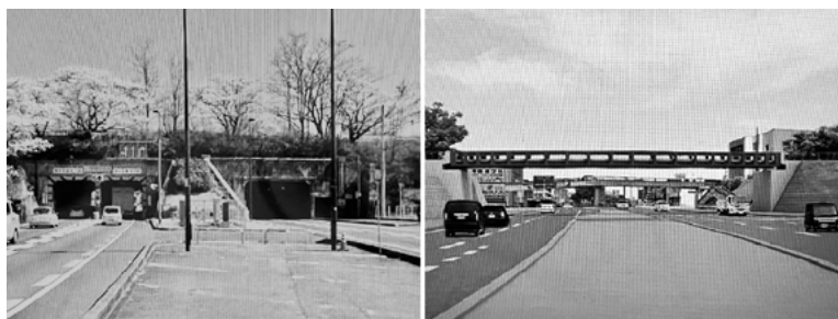
図13：トンネル撤去工事前の草津川の川床の下を通過する国道1号線（左側）と撤去工事後の予想図（右側、ともに国土交通省近畿地方整備局の配付資料から）
