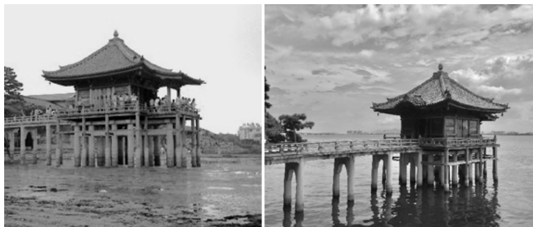
図11：平成6年（1994年）9月の水位マイナス112センチの洪水時の浮御堂（左側、安土の歴史散歩と風景から引用）と平水時の浮御堂（右側、筆者撮影）。洪水時の写真では浮御堂を支える柱が根元から露出している。
