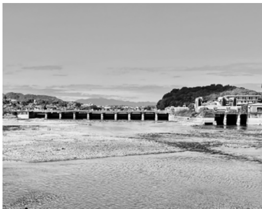
図10：下流側から見た新瀬田川洗堰の全景（筆者撮影）。左手にある10門の水門が昭和36年（1961年）に総工費4億6,500万円で整備された新瀬田川洗堰で、その右手にある3門の水門が平成4年に（1992年）に整備されたバイパス水路。新瀬田川洗堰は全長173メートルの鉄筋コンクリート造りで、幅10.8メートルの2段式ローラーゲートを装備した水門を10門備え電動で開閉される。最大疎通能力は毎秒600トンで、その後に創設された低水位用のバイパス水路の毎秒200トンと合わせて800トンの疎通能力がある。バイパス水路の後方には明治の改修工事で西側が削りとられた大日山が見えている。
