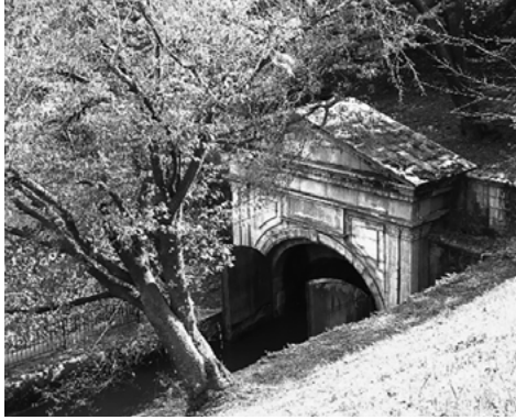
図1：琵琶湖疏水第一トンネル東口の鉄扉（筆者撮影）。入り口の両側に鉄製の観音開きの2枚の扉が見えており、水面下のみえない部分には四角い穴が2箇所、両扉で4箇所開いている。この扉は琵琶湖の洪水の時に閉められ、疏水路を保護し奔流が京都市内へあふれ出るのを防止すると共に毎秒8トンという第一疏水で約束された通水量を保証する役割を担っている。しかし設置されてからまもなく旧瀬田川洗堰（南郷洗堰）ができて琵琶湖の洪水調節が国の管理で行われるようになったため、この扉は設置されてから閉められたことはない。
