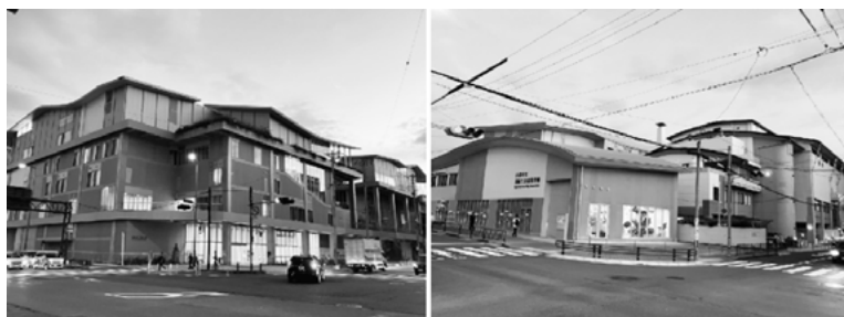
図100：京都駅の北東側の崇仁地区の再開発地に移転した京都市立芸術大学（左側）と京都市立美術工芸高等学校（右側）（筆者撮影）。京都市立芸術大学は230億円をかけて建設され、間近に移転した京都市立美術工芸高等学校と共に一大芸術ゾーンを形成している。
