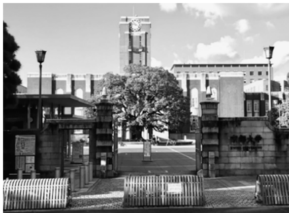
図90：京都大学の時計台の 現況写真。時計台は、建築学科初代教授・武田五一が設計して大正14年（1925年）に完成し、ゼツェシオンの意匠を随所に留め、その外観は格調高い風格を備え、歴史的にも貴重な存在となっている。当時最新の鉄筋コンクリート造りで作られ、ホールの大スパン架構は、アングル・プレートのリベット組立て鉄骨トラス梁となっている。かつて法経学部の講義施設として使われ、近年は本部事務局として歩んできたが、平成15年（2003年）に百周年時計台記念館となっている。
